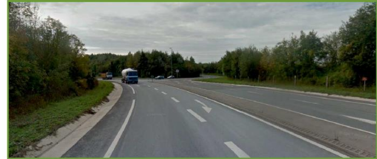
Le paysage d'infrastructures
